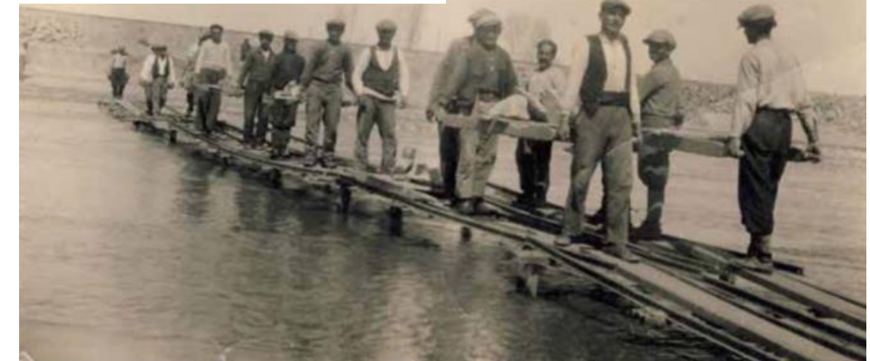
Συλλογή φωτογραφιών περιφέρειας Σερρών. Εργαζόμενοι στα έργα, κοντά στον Αγγίτη, μεταφέρουν πέτρα, γύρω στο 1935. Πηγή: Γ.Α.Κ. - Αρχεία Ν. Σερρών
