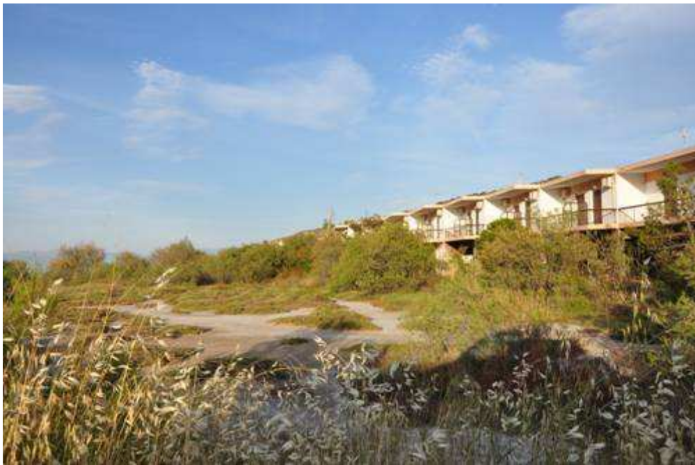
Εικ. 12. Στην περιοχή του Ατσίγγανου υπάρχουν μόνιμες κατασκευές εντός υγροτοπικής περιοχής
